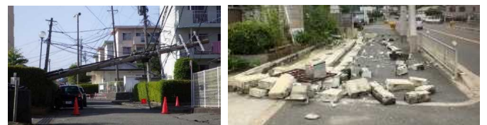
電柱の倒壊による道路閉塞の事例(平成28年熊本地震)
