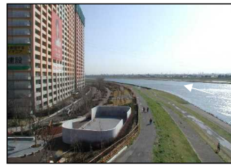
高規格堤防の整備(江戸川:市川南地区)
