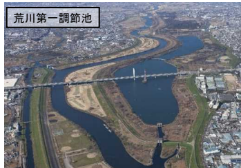
洪水調節施設の整備
