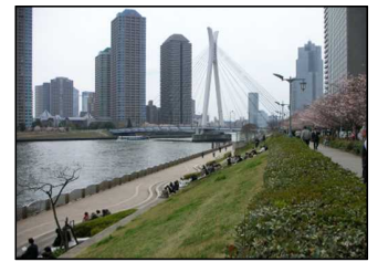
スーパー堤防の整備(隅田川:新川地区)
