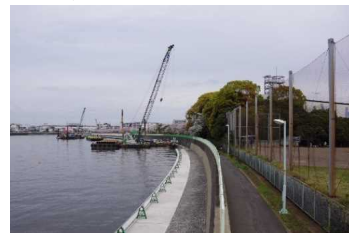
堤防の耐震対策(中川:高砂地区)
