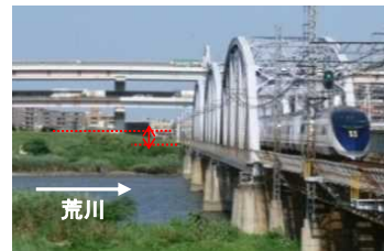
京成本線荒川橋梁架替
