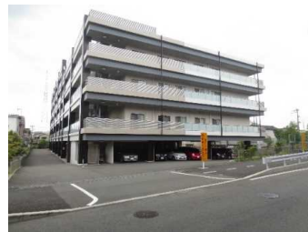
建築物のピロティ化(大阪府堺市)
