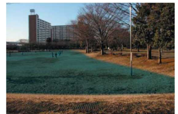
公園貯留施設(葛飾区:新小岩公園)
