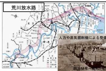
放水路の整備
