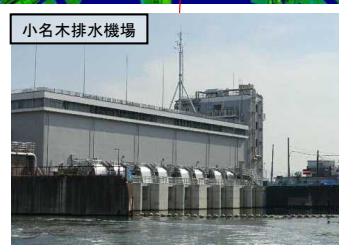
江東内部河川の水位を低下させる排水機場の整備
