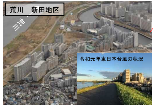
国による高規格堤防・都によるスーパー堤防の整備 (住宅市街地総合整備事業等と実施)
