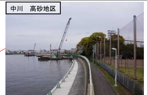
堤防の耐震対策
