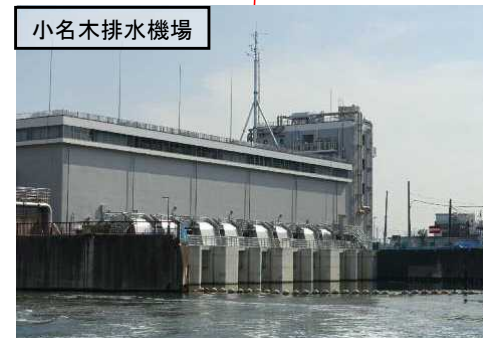
江東内部河川の水位を低下させる排水機場の整備
