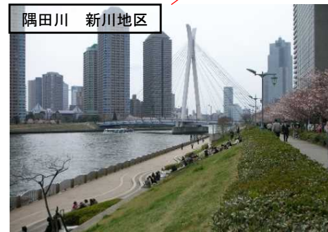
都によるスーパー堤防の整備
