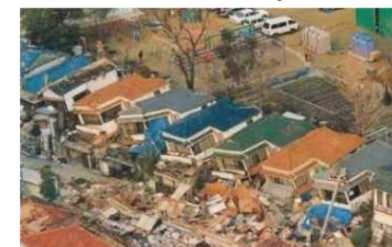
道路沿道建築物の倒壊による道路閉塞の事例(平成7年阪神淡路大震災)
