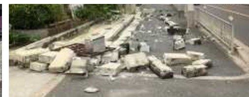
ブロック塀等の倒壊による道路閉塞の事例 (平成30年大阪北部地震)
