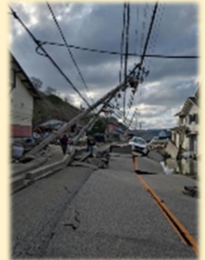
電柱倒壊等による道路閉塞
