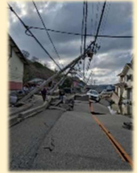
電柱倒壊等による道路閉塞
