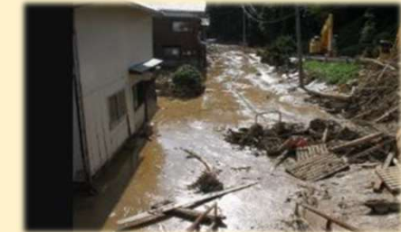
浸水被害にあった家屋(珠洲市)
