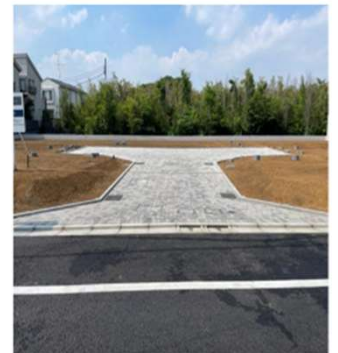
宅地開発における無電柱化実施事例
