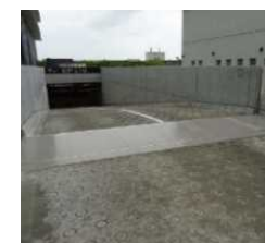
地下駐車場入口にある起伏式防潮板の一例
