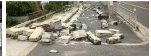
ブロック塀等の倒壊による道路閉塞の事例 （平成30年大阪北部地震）
