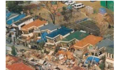
道路沿道建築物の倒壊による道路閉塞の事例（平成7年阪神淡路大震災）
