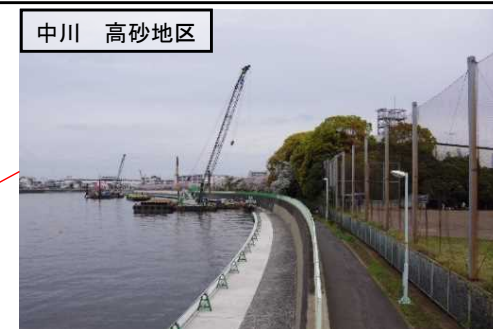
堤防の耐震対策
