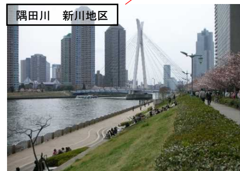
都によるスーパー堤防の整備
