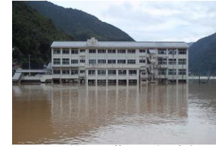
H26. 8 避難所2階の浸水(徳島県)
