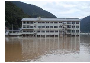
H26. 8 避難所2階の浸水(徳島県)
