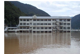
H26. 8 避難所2階の浸水(徳島県)
