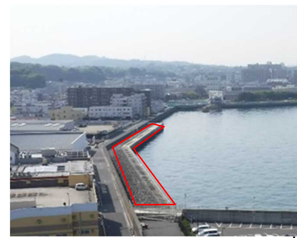
整備後の様子(令和元年撮影)
