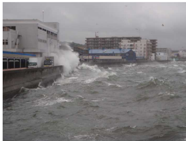
整備前の越波状況(平成20年撮影)
