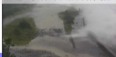
台風第19号の高波状況(焼津市吉永地先)
