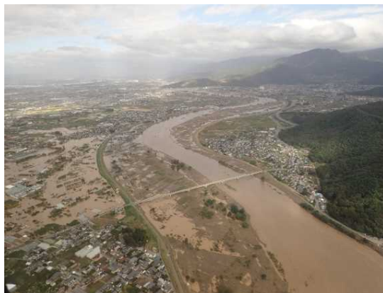
長野県長野市 被災状況
