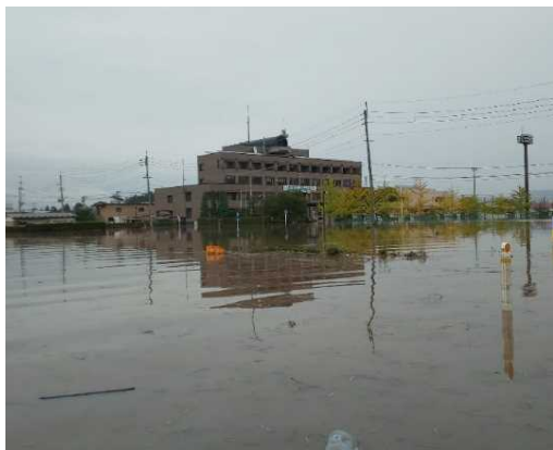
宮城県丸森町 被災状況
