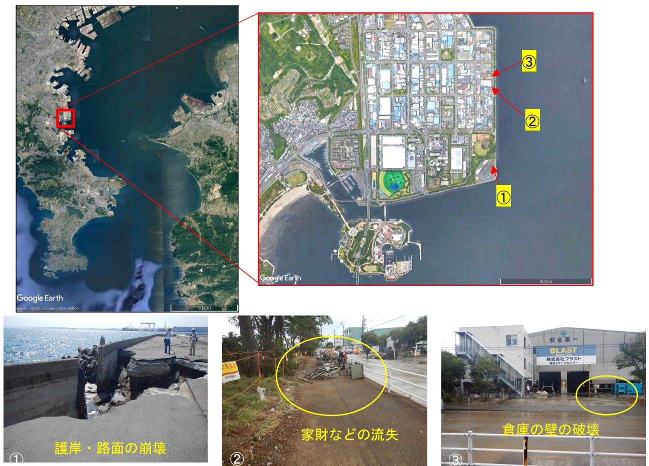
図 3.1 福浦地区の位置図と令和元年台風第 15 号による被害の状況
