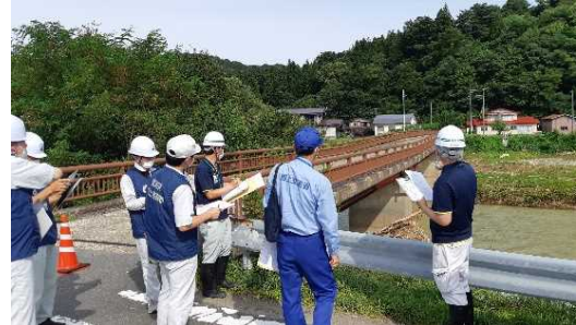
緊急調査状況(開晴橋(町道山子線))
