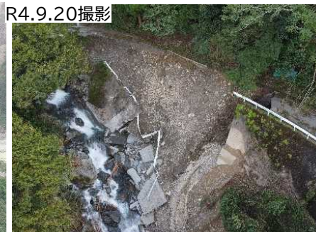
町道 山瀬橋・長崎線(美郷町)
