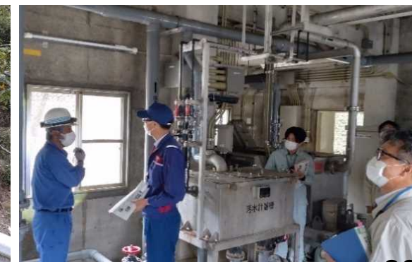
緊急調査状況(諸塚浄化センター)
