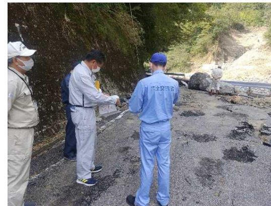
緊急調査状況(村道 尾前下線)
