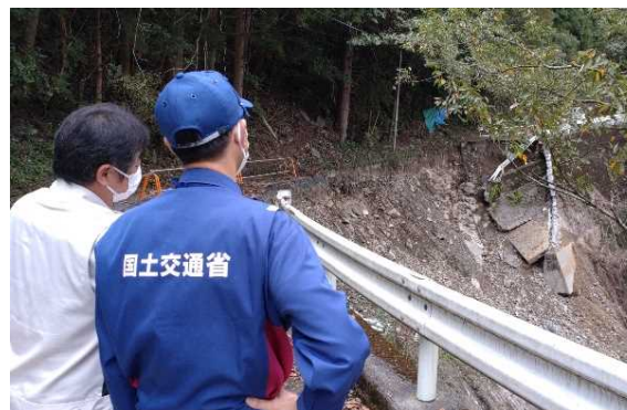
緊急調査状況(町道 山瀬橋・長崎線)
