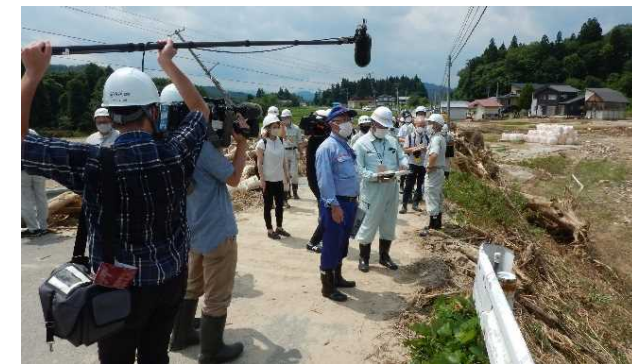
緊急調査状況(一級河川小白川・大巻橋(県道長井飯豊線))
