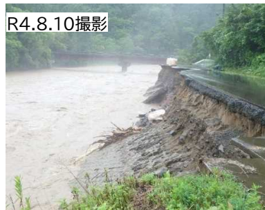
二級河川追良瀬川(町道松原1号線)
