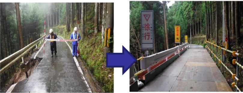
応急復旧 (左：被災後 右：対策後)
