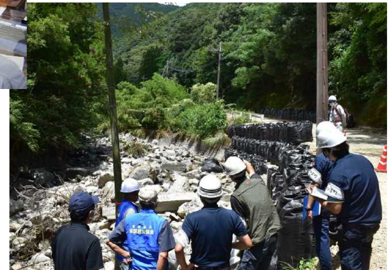
被災メカニズムの確認 (道路の被災)
