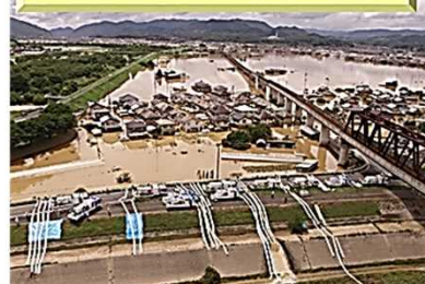
【H30.7豪雨】 (岡山県倉敷市真備町)
