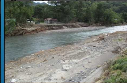
⑦右岸側の溢水被災状況
