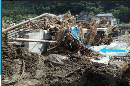
①中の橋の流木閉塞状況
