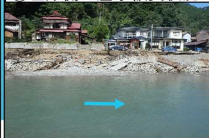
②左岸側の溢水被災状況
