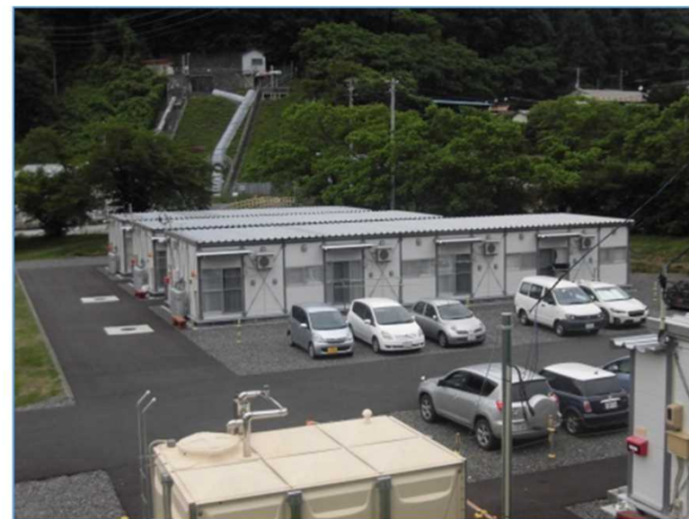
仮設住宅設置状況 7
