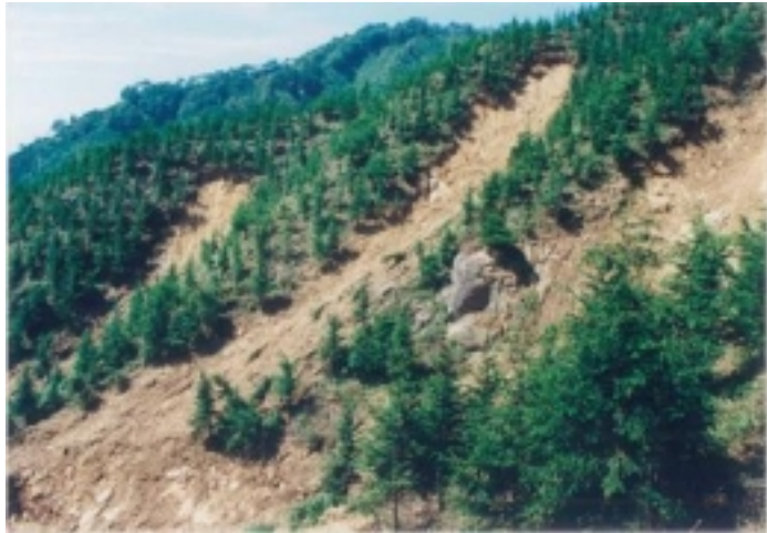
伐採跡地の崩壊状況 (長野県下伊那郡根羽村 井戸入)
