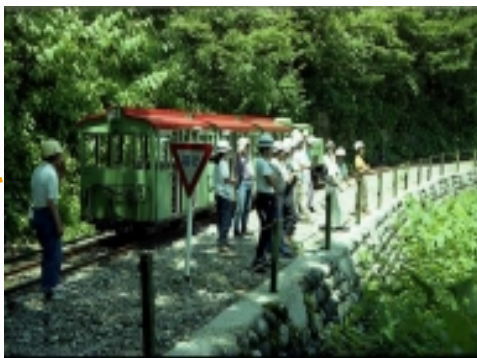
トロッコで砂防の現場へ【見学会】
