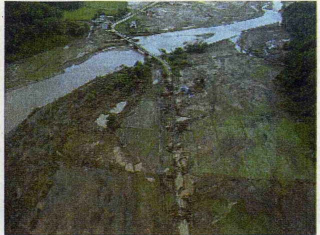
あっぺつ 二級河川厚別川と びゅうあつがていしやじょう もんべつ 道道比宇厚賀停車場線(門別町)
