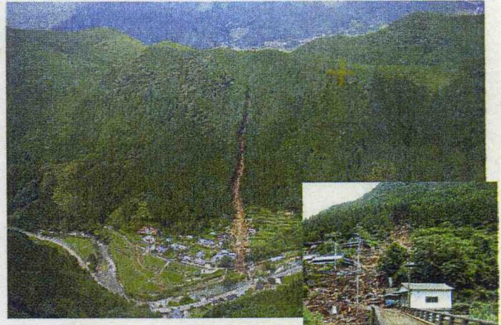
土砂災害 (水俣市深川新屋敷地区) みなまた ふかがわしんやしき
