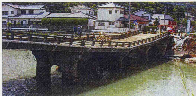
市道江南橋・古城線 つるた みなまた 市道江南橋・古城線 鶴田橋 (水俣市)
