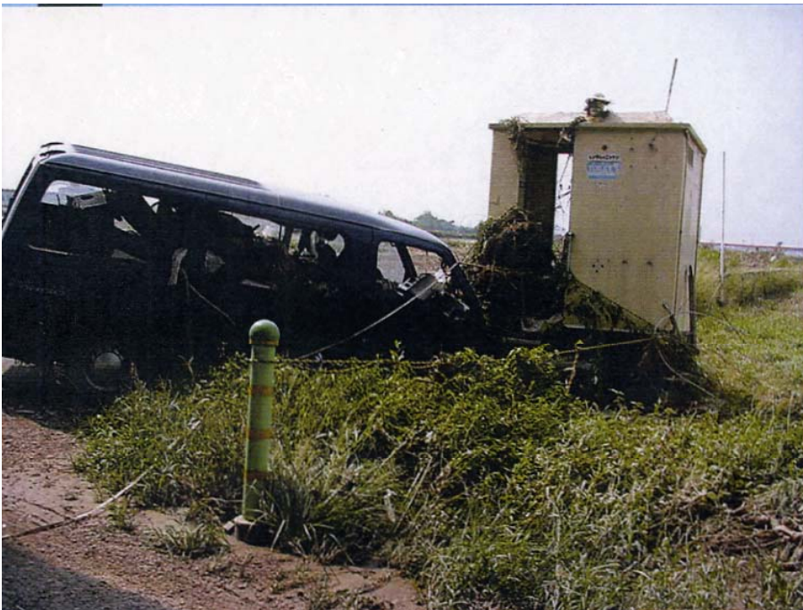
出水前に撤去されなかった簡易トイレの状況
