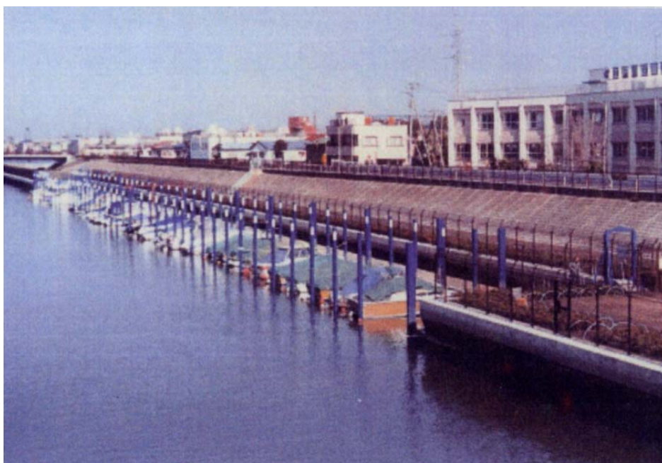
不法係留船対策の一環として、整備された新中川の暫定係留施設
