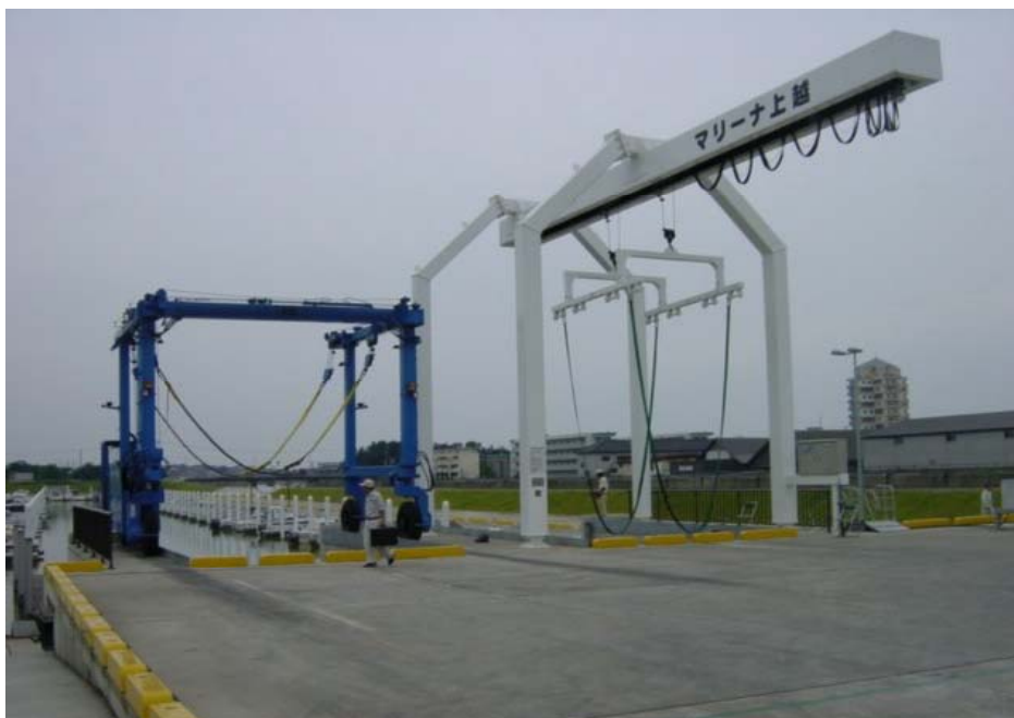
マリーナ上越が占用し、設置している船舶上下架施設
