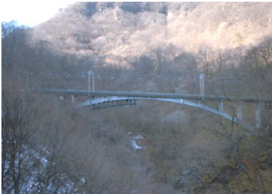
碓氷川に架かる旧信越線（平成9年10月廃止）の鉄道橋梁
