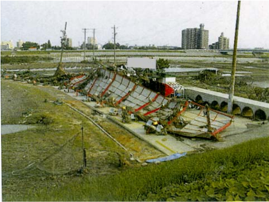
出水前に撤去されなかったゴルフ場施設の状況
