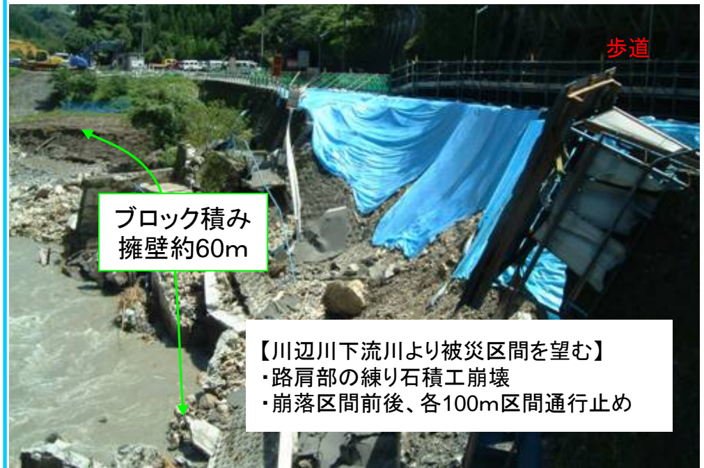
■ 国道445号(熊本県五木村築切地先)
