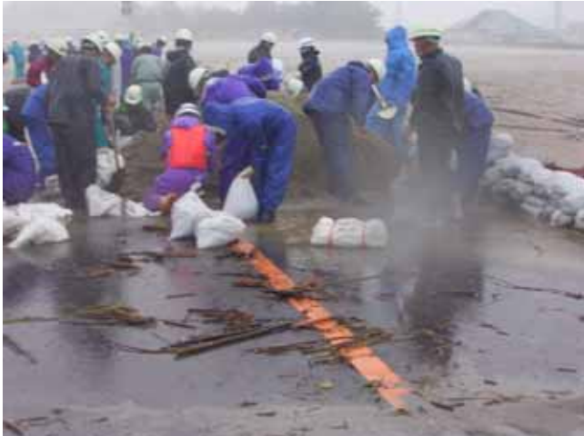
岡富地区の土のう積み状況(五ヶ瀬川) 平成17年9月6日、台風14号
