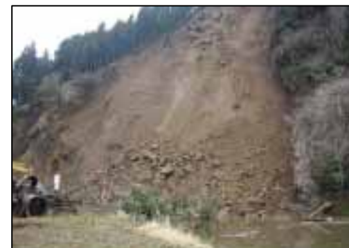
二級河川 河原田川 輪島市熊野 河道閉塞(L=30m、H=40m)
