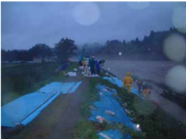
新潟県小千谷市上片貝地先において シート保護を実施(信濃川) 平成17年6月28日、梅雨前線出水 提供:信濃川河川事務所
