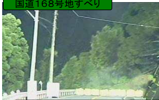
国道168号地すべり
