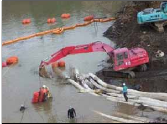
芋川河道閉塞箇所での排水作業 (出典:北陸地方整備局ホームページ)
