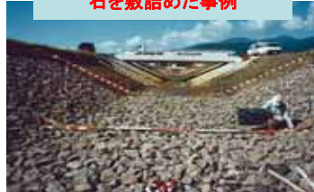
定規断面で施工し、河床に石を敷詰めた事例
