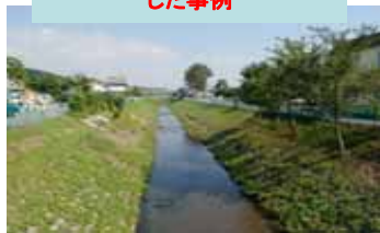
蛇行河川を直線化して改修した事例
