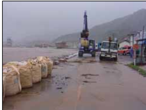
宮崎県五ヶ瀬川で大型土のう積みを実施 (平成17年9月6日 台風14号)
