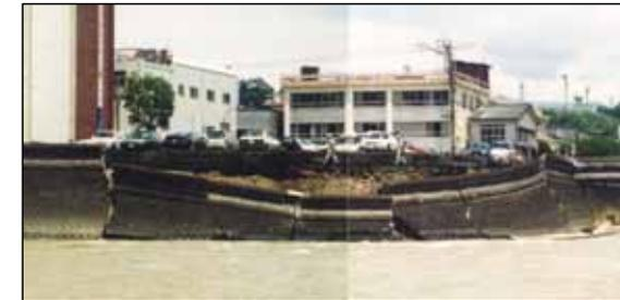
基礎洗掘により護岸が崩壊した球磨川の事例(山田川合流点(H8.7.3~8の出水後))
