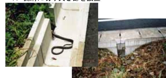
道路下に横断管（小規模なトンネル）を設置することにより、道路の反対側へ移動することが可能。
