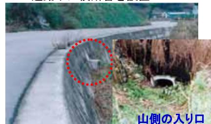
4. 側溝に切り欠き部を設置
