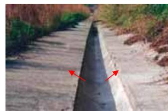
のり面小段部に設置する側溝に緩傾斜型の側溝を用いることにより、側溝内に小動物が落下しても簡単にはい上がることが可能。
