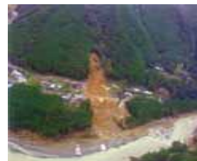
上流部の土砂災害 (H16.9)
