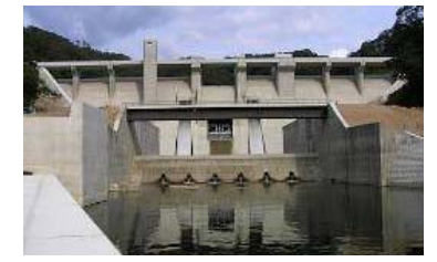
灰塚ダム(H18完成)
