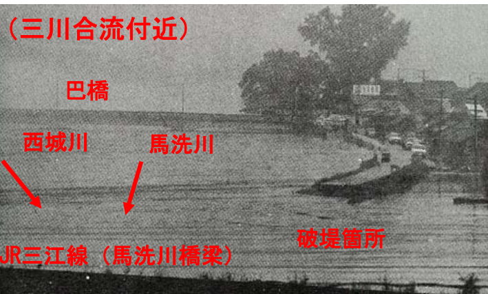
昭和47年7月洪水による破堤状況
