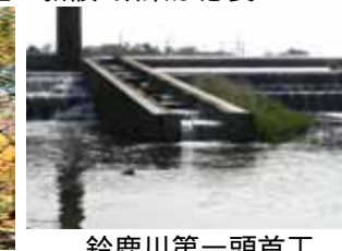
鈴鹿川第一頭首工に設置された魚道
