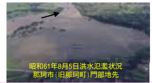
昭和61年8月5日洪水氾濫状況 那珂市 (旧那珂町) 門部地先
