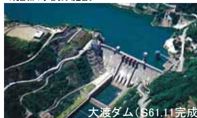
既設洪水調節施設
