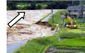
天竜川の堤防決壊状況 (H18.7洪水)
