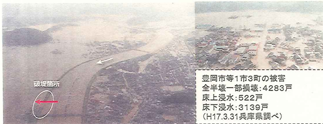
【事例1】 円山川水系円山川の状況(兵庫県 平成16年10月台風23号)
