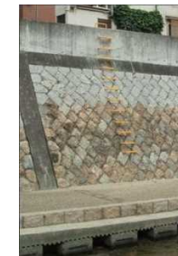
兵庫県 都賀川 ～避難はしごの設置例～
