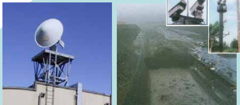
水害・土砂災害監視機器の設置・修繕
