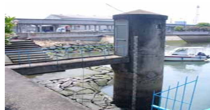
潮位計等の観測施設の設置
