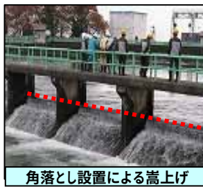
角落とし設置による嵩上げ
