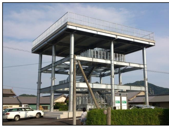
◆ 津波避難タワー （高知県四万十町興津）
