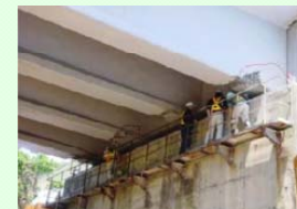
目視、打音検査
