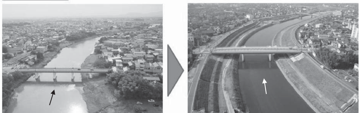
②築堤・河道掘削 五十嵐川 常磐橋
