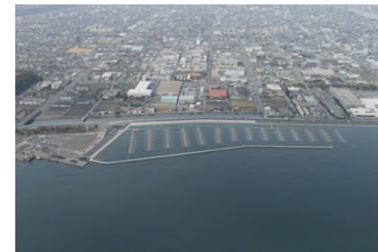
【海岸堤防の整備】 福山港一文字地区
