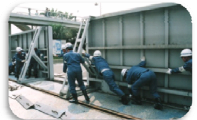
(陸閘の閉鎖作業)
