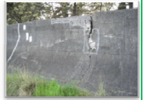
(堤防のひび割れ)
