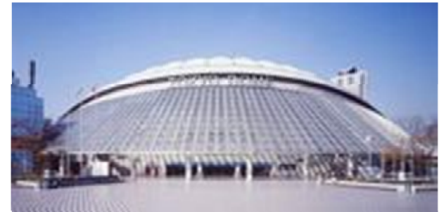
出典：株式会社東京ドームHPより
