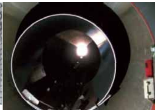
サイホン内に鋼管を挿入し補強
