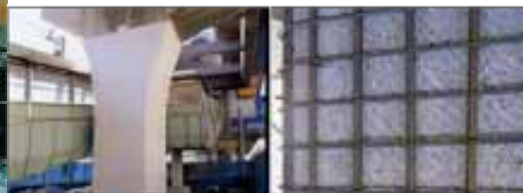
橋脚に鉄筋を追加
