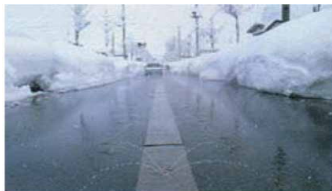
消雪用水散水状況
