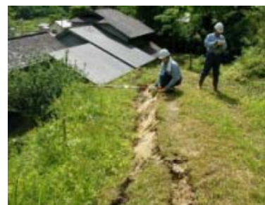
TEC-FORCEによる緊急点検・対策
