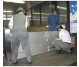
止水板の設置等
