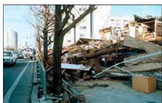
住宅やビルの倒壊
