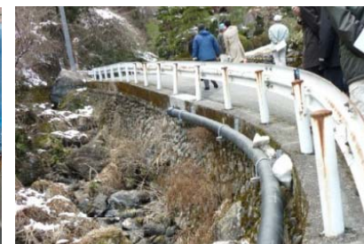
クイック配管(露出配管)
