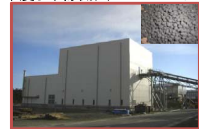
宮城県県南浄化センター【造粒乾燥】 （平成21年度より稼働）（50t-wet/日）
