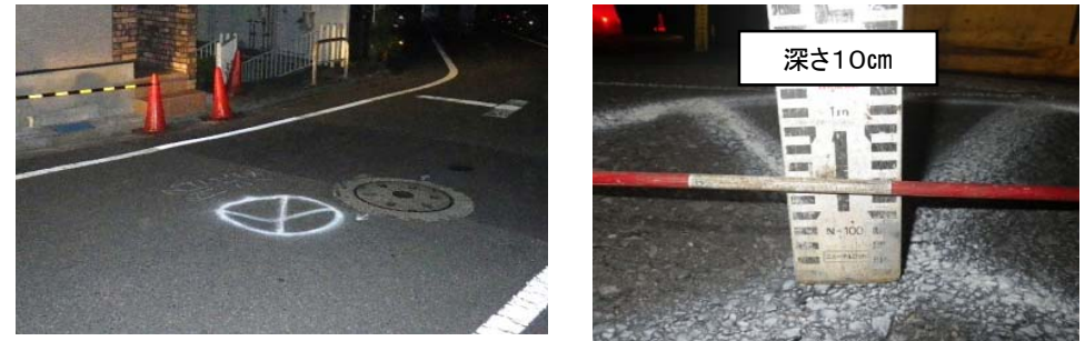
東京都北区での陥没事例(平成25年8月)
