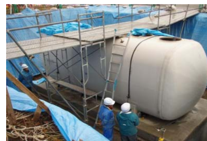
工場製作型極小規模処理施設
