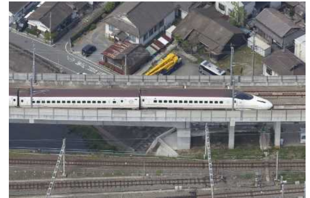
新幹線脱線(熊本駅南側)
