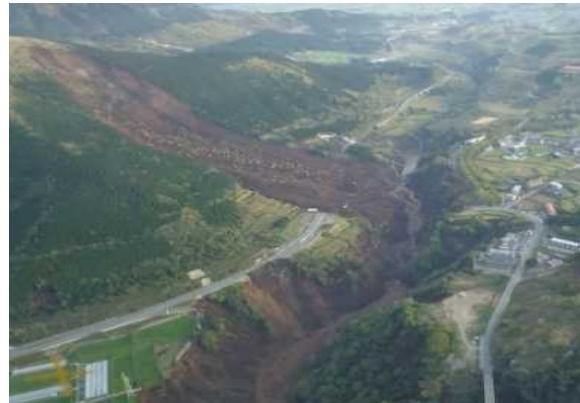
斜面崩壊による道路、鉄道の寸断
