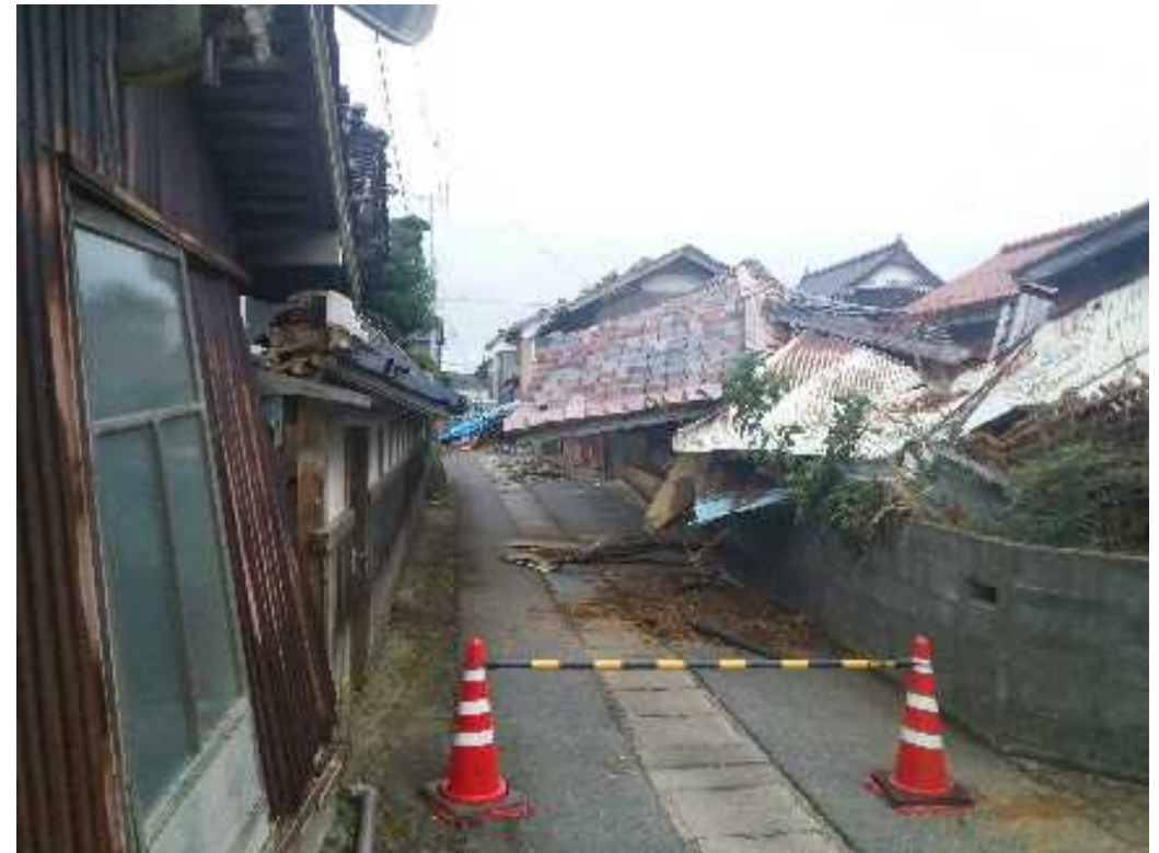
家屋の被災状況（鳥取県北栄町）
