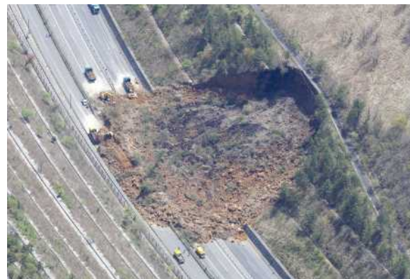
土砂崩落(大分道由布岳PA付近)
