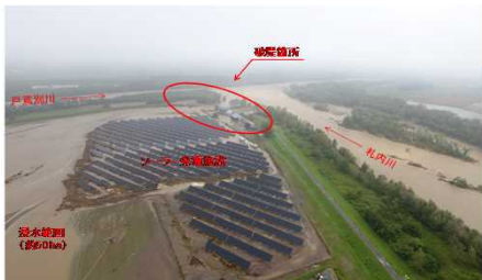
札内川の堤防決壊状況（帯広市）
