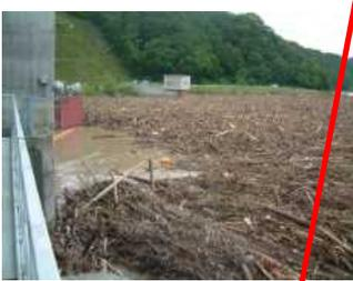
二風谷ダムでは、ダム計画規模を上回る流入量を記録。しかし、常に流入量より少なく放流し、ねばり強く運用することにより、ダム下流の洪水被害を大幅に軽減すると共に流木災も防止。
