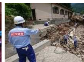
公共土木施設の被災状況調査 平成29年九州北部豪雨(福岡県東峰村)
