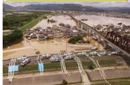
【H30.7月豪雨】 (岡山県倉敷市真備町)
