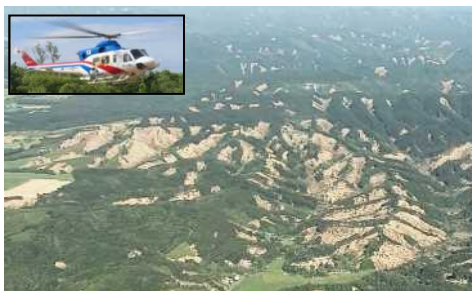
防災ヘリによる被災状況調査 (北海道勇払郡厚真町)
