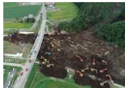
河道閉塞箇所において24時間体制で土砂撤去を実施 (北海道勇払郡厚真町・厚真川幌内橋付近)
