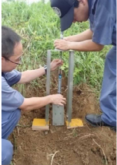
堤体土質の引張試験の実施状況
