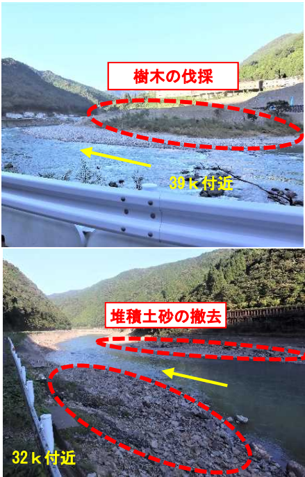
樹木の伐採や部分的な堆積土砂の除去
