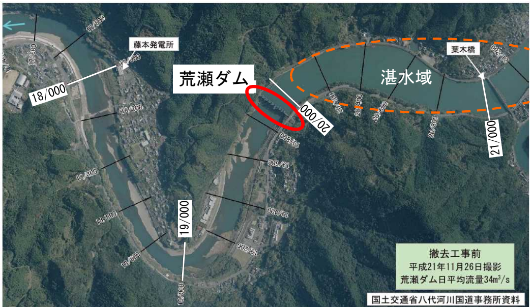
河川形状 荒瀬ダム撤去前
