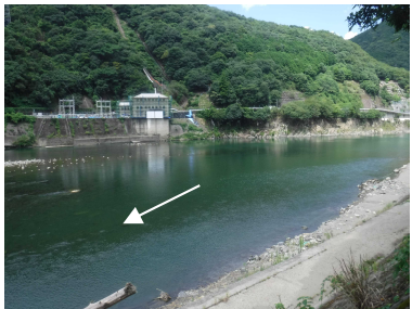
上流側の状況 (R3. 8撮影)
