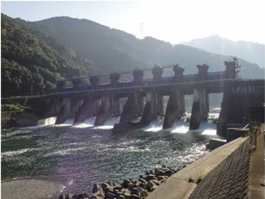
荒瀬ダム（平成30年3月撤去）
