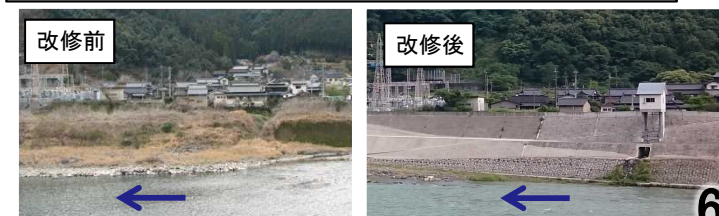
かさ上げ実施事例（八代市坂本町藤本地区）
