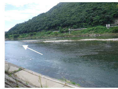
下流側の状況 (R3. 8撮影)
