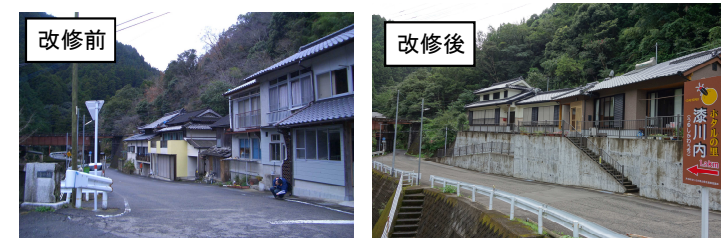
かさ上げ実施事例（芦北町漆川内川地区）
