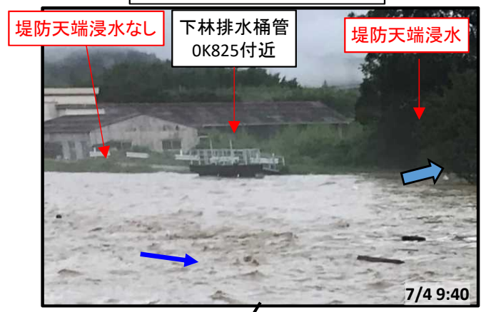
万江川(下林排水樋管(左岸))
