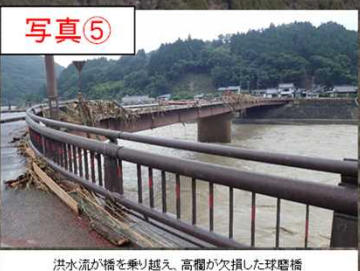
洪水流が橋を乗り越え、高欄が欠損した球磨橋
