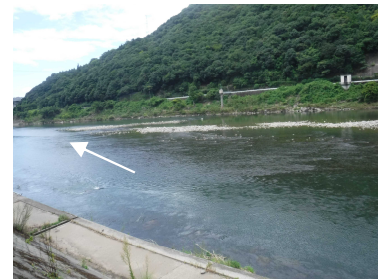
下流側の状況 (R3.8撮影)
