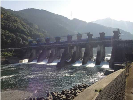
荒瀬ダム（平成30年3月撤去）
