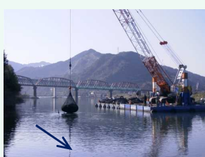
萩原地区の深掘対策状況(八代市)
