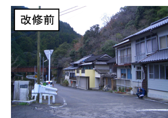
かさ上げ実施事例（芦北町漆川内川地区）
