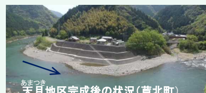
天月地区完成後の状況(芦北町)
