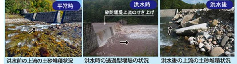
流域内で整備している透過型砂防堰堤は、中小出水時には土砂は通過するが、洪水時には土砂を捕捉(写真は戸蔦別川第5号砂防堰堤の事例)
