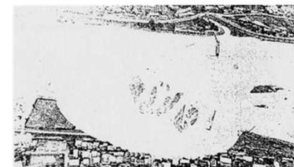
二ヶ領河原堰堤左岸側の本堤が決壊したため、堤内地を大きく迂回する濁流
